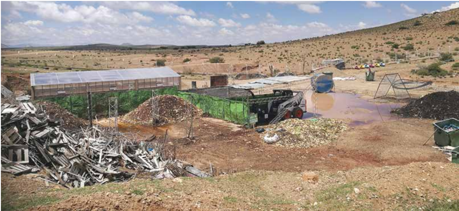
Planta de compostaje de relleno sanitario, Villazón. Foto: Alfredo Wolff
